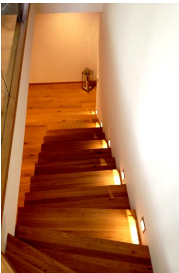
Typische Installation an jeder dritte Stufe
