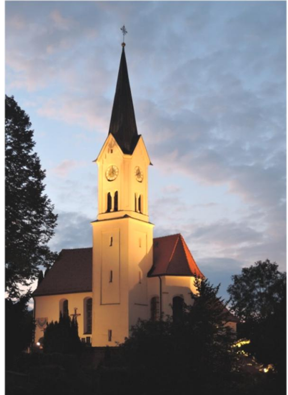
Objektbeleuchtung im Außenbereich
