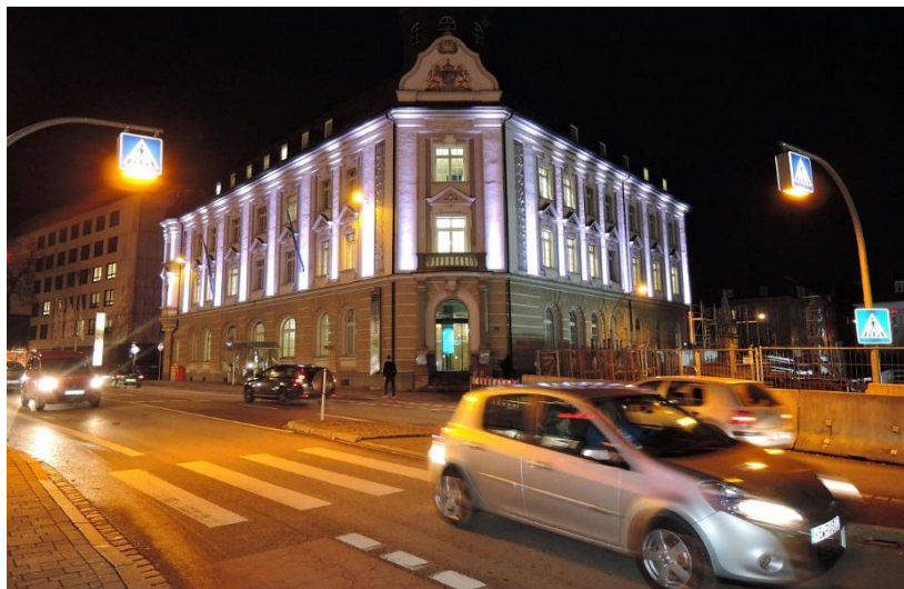
Fassadenbeleuchtung mit YES-LED-Wallwashern
