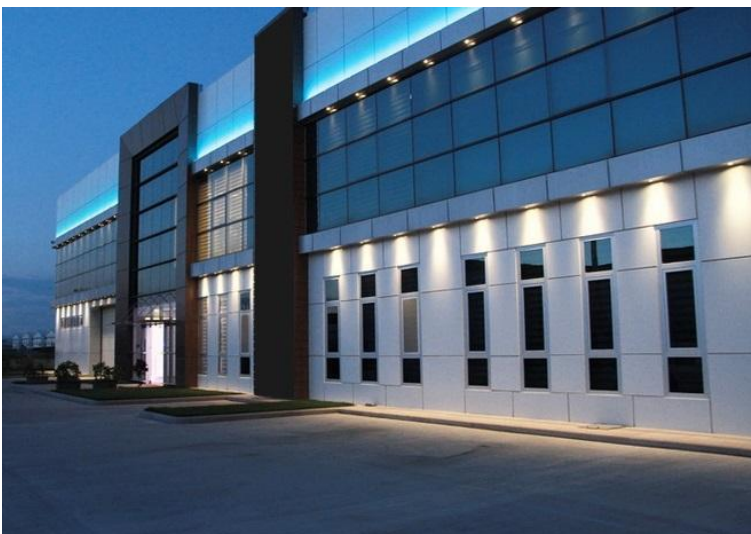
Fassadenbeleuchtung mit YES-LED-Wallwasher
