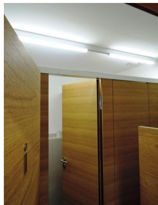
Durch einen 180° Abstrahlwinkel ergibt sich auch ein indirekter Lichtanteil
