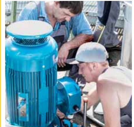
Carsten Kube und Patrick Schmidt bei Revisionsarbeiten am Faulschlammischer
