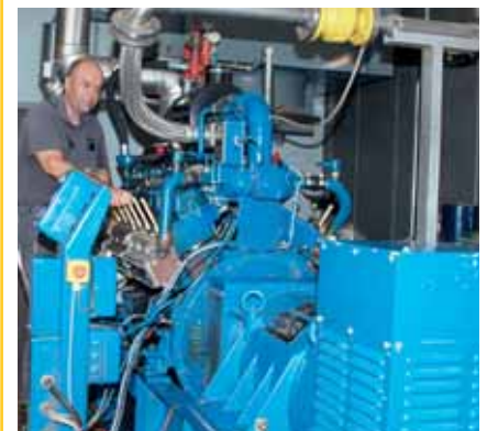
Roland Fink am Klärgasmotor mit einer Leistung von 230 PS und 22 Liter Hubraum
